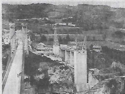
De 1924 à 1928, le nouveau pont de la Caille en construction.
